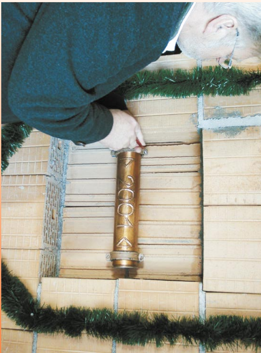
Herr Schwenk montiert das Rohr mit der Grundsteinurkunde
