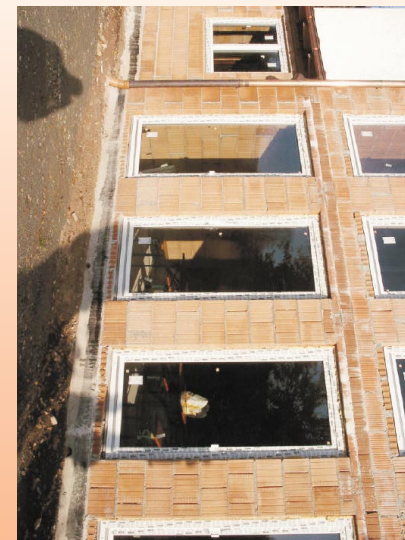
Der Rohbau ist fertig
